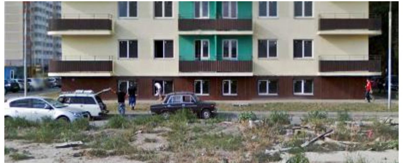
Фасад до реконструкции.
