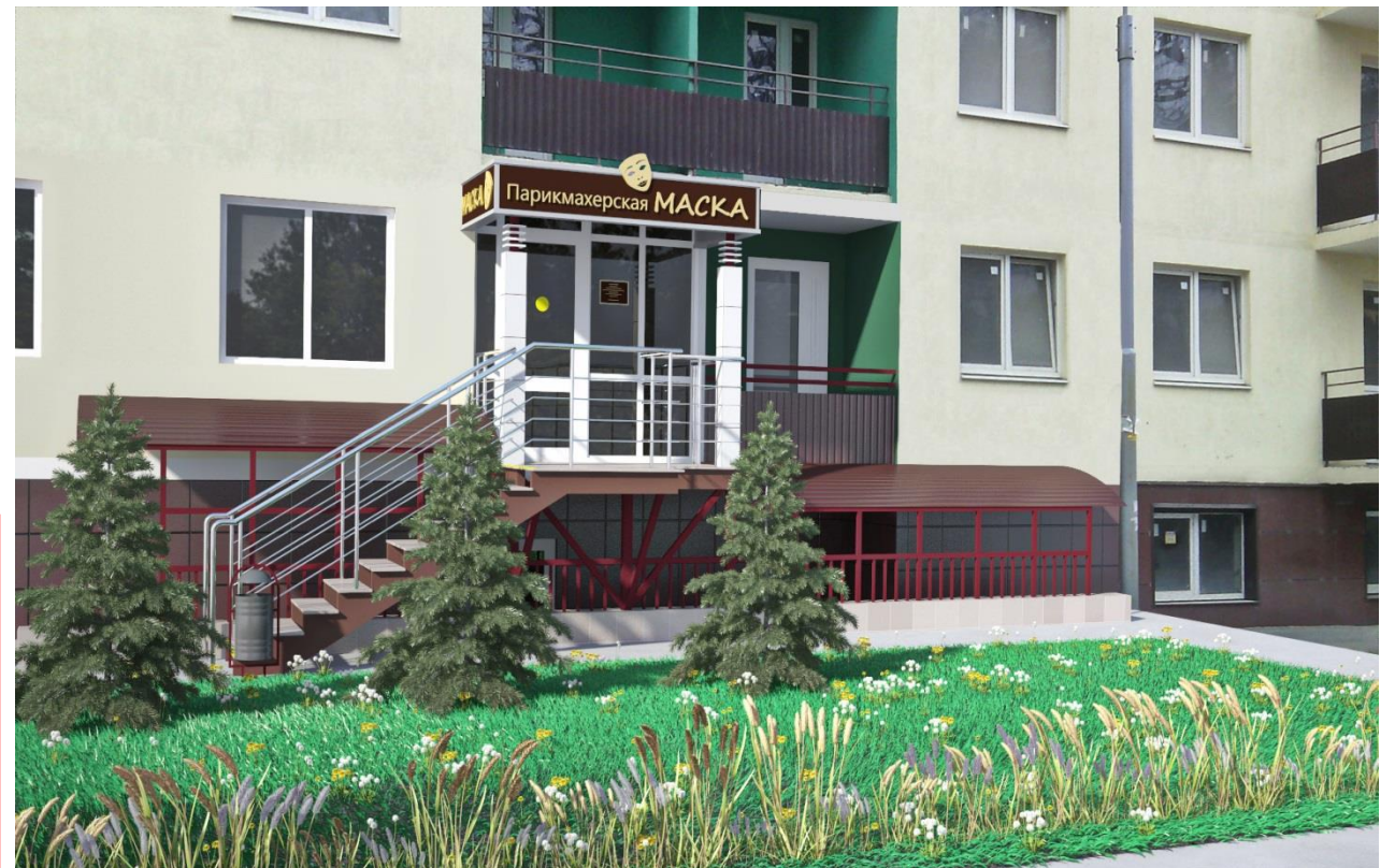
Вид фасада после реконструкции.
