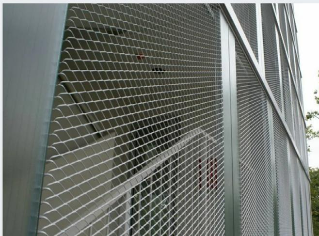
Рис. 4. Пример частичной защиты антидроновыми сетями критического узла объекта охраны.
