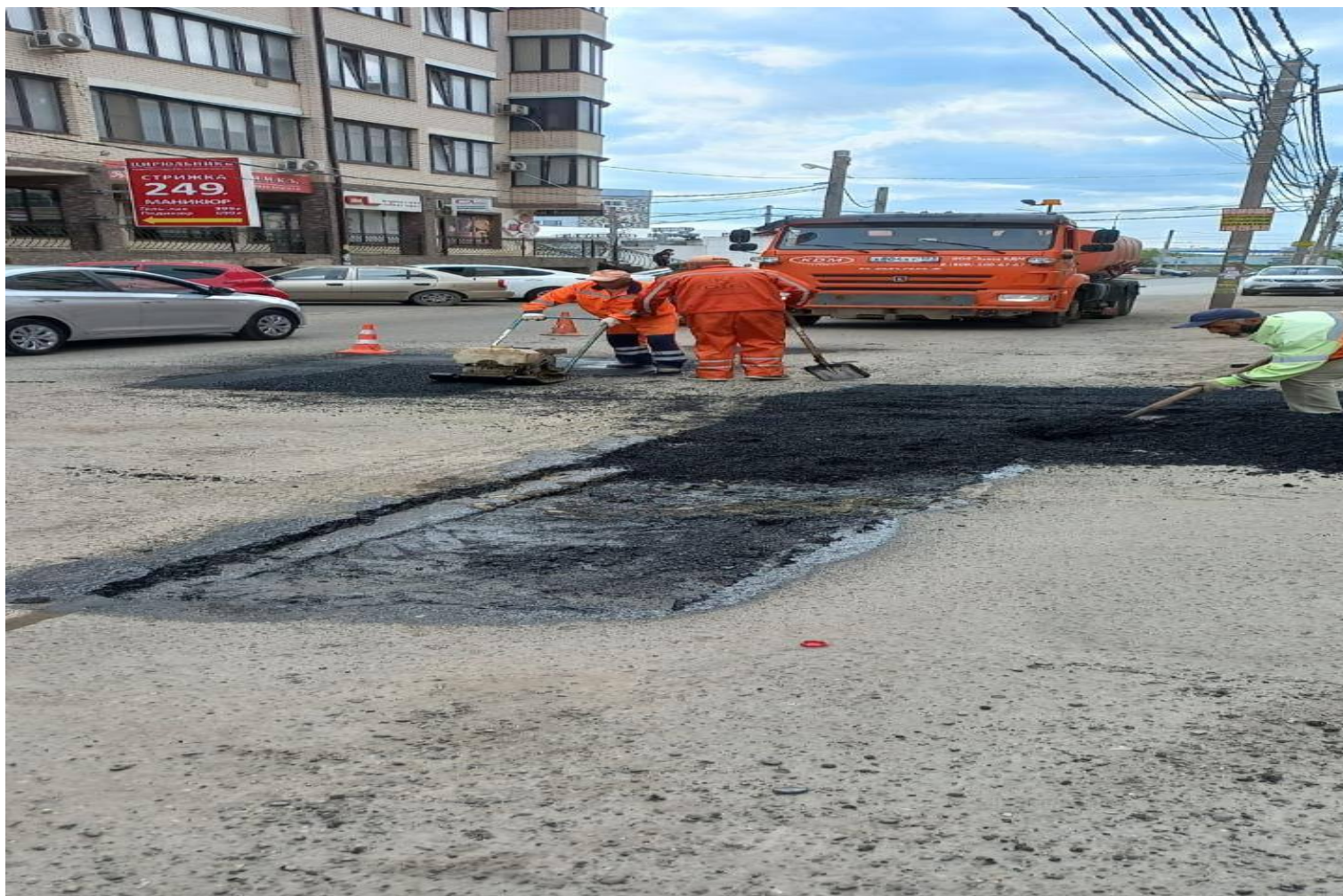
ул. Гомельская (1160 м2)
