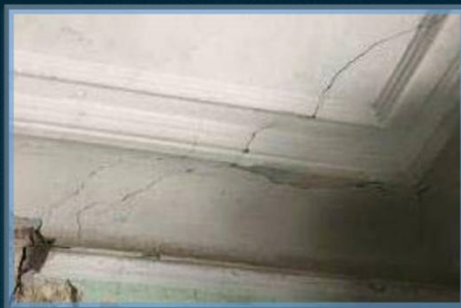
Отделка потолков в виде падуги с двумя профилированными тягами, а также штукатурная отделка гладки стен и потолков.
