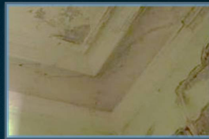
Отделка потолков в виде падуги с двумя профилированными тягами, а также штукатурная отделка гладки стен и потолков.
